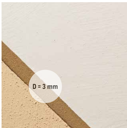
Beispiel mit CLAYFIX Lehm-Anstrich System
